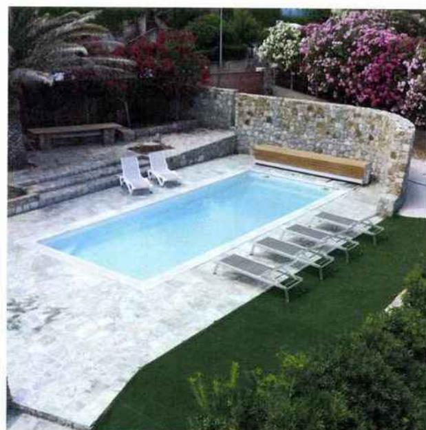
La rapidité d'exécution, la solidité et la bonne étanchéité sont les principaux avantages de la piscine polyester. Le gel coat, présent en finition, renforce et protège la surface intérieure finie de la piscine. La piscine fait 10 m par 4 avec un fond en pente régulière allant de 0,90 m à 1,82 m. **Alliance Piscines**
