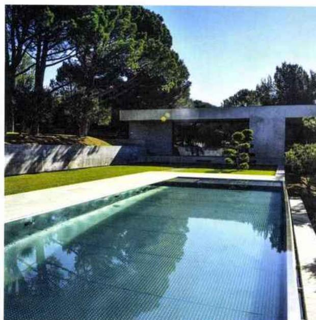
Un couloir de nage avec une structure autoportante en inox composée de 5 sous-ensembles : parois, éléments encastrés (escaliers...), canaux de distribution de l'eau, fond (plaques soudées avec les parois) et équipements. **Steel and Style**
