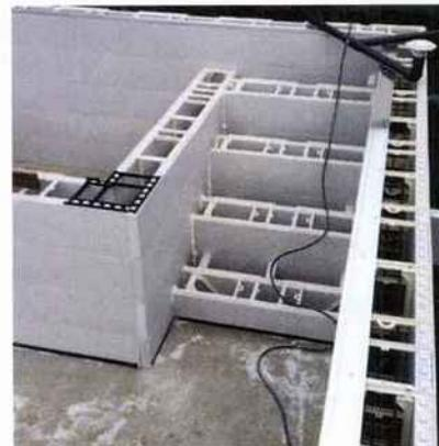
Le procédé de coffrage intègre des panneaux isolants en polystyrène haute densité (30 kg/m<sup>3</sup>) et des pièces de liaison en polypropylène permettant leur assemblage. Armée verticalement et horizontalement par des aciers filants, la structure est prête à recevoir le béton. **Keeps**
