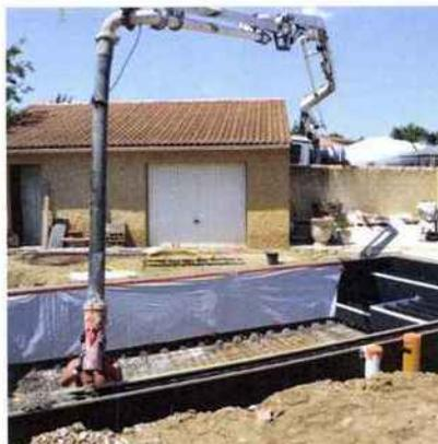
La structure modulaire, brevetée, est composée de panneaux en polypropylène à coffrage perdu et permet de changer le liner sans risque de fissuration des margelles. La construction de la piscine nécessite 6 à 8 jours, avec 4 semaines de séchage de béton. **Piscines Magiline**
