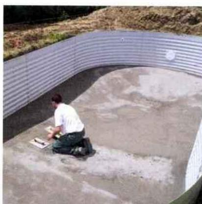
L'ossature est constituée de panneaux en acier ondulé de forte épaisseur (alliage métallique constitué principalement de fer et de carbone), recouverts de Galfan ainsi que d'une couche de PVC, apportant une protection supplémentaire à la structure. **Piscines Waterair**
