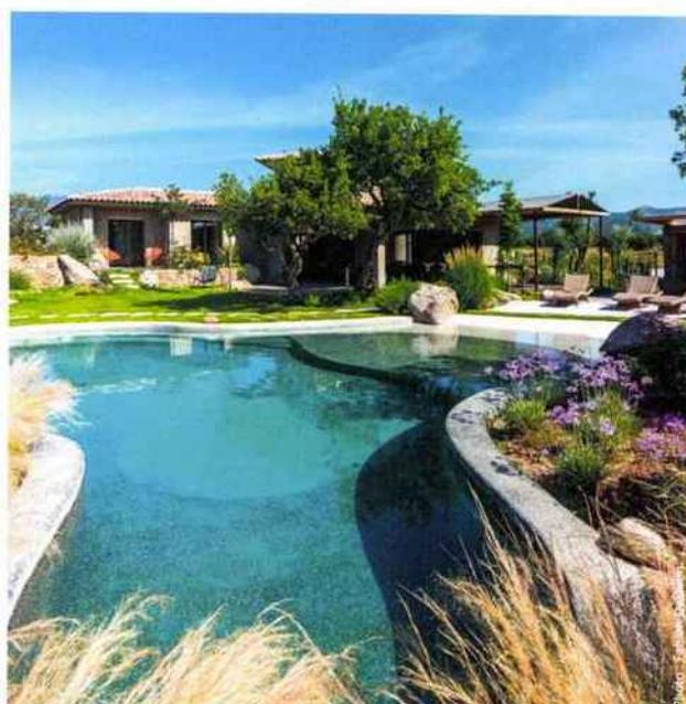
*Le procédé Leader Pool assure une structure en béton armé monobloc. Le fond, les parois et la plage sont coulés en une seule opération. Les dimensions de ce bassin sont de 12 m par 8 m avec un fond allant de 1,30 m à 1,60 m. Vert Turquoise*
