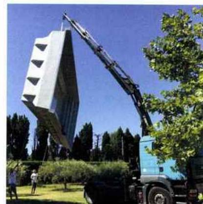
Construite d'un seul bloc, la coque est constituée en résine de polyester, matières thermodurcissables, résistantes à la corrosion. Une barrière contre les phénomènes d'hydrolyse est appliquée pour assurer l'imperméabilité de la structure. **Génération Piscine**
