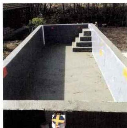
Le système de coffrage breveté avec des panneaux de structure écologique (réalisés en plastiques recyclés) permet une meilleure répartition du béton à l'intérieur des murs. L'ouvrage en béton armé est totalement monobloc et autoportant. **Unibéo Piscines**
