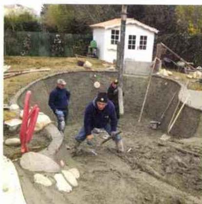
*Cette structure ferrailage est en ST 25 avec raidisseurs 10 x 10 tous les 50 cm. Une grille spéciale maintient le coulage. Pour éviter tous les vides, le béton armé est coulé par l'arrière et vibré. Puis, il est lissé de suite pour éviter les rajouts d'adhérence aléatoire. Iléo*
