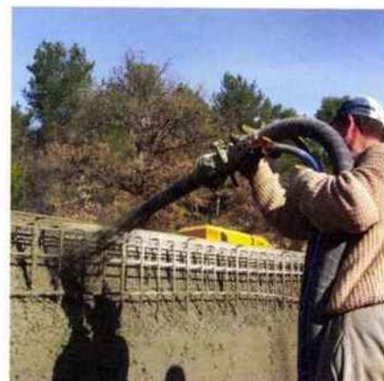
*Le béton est projeté à grande vitesse, à raison de 380 kg à la minute sous une pression de 7 bars avec un canon à béton, sur le ferrailage. La projection par gunitage permet de réaliser des piscines de toutes formes et dimensions. Piscines Jacques Brens*
