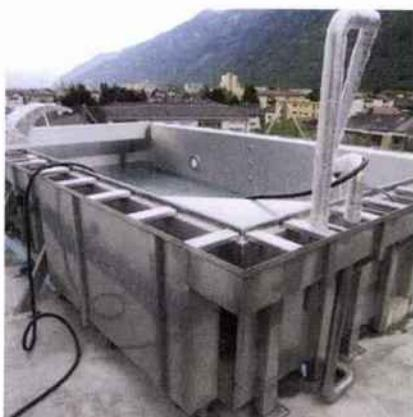
Modèle Diamond Grey, cette piscine est en acier inoxydable finition brossé, qualité 316L, avec un bac tampon faisant partie intégrante du bassin. L'assemblage et le soudage des différents éléments se font directement sur le site. **Ecoeur Frères**
