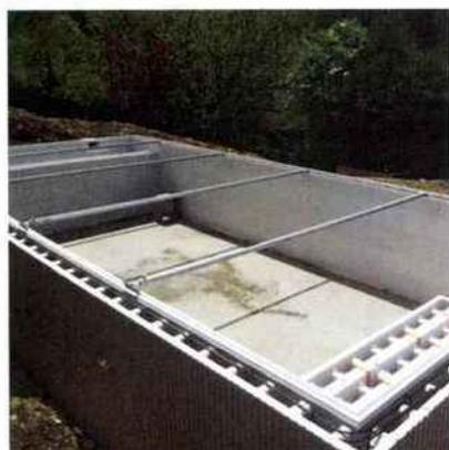
La structure est constituée de modules en polystyrène expansé haute densité. Les murs sont réalisés en béton armé de 16 cm d'épaisseur et le ferrailage est composé d'aciers horizontaux à chaque rang de blocs et d'aciers verticaux tous les 50 cm. **Ascomat - Piscines Virginia**
