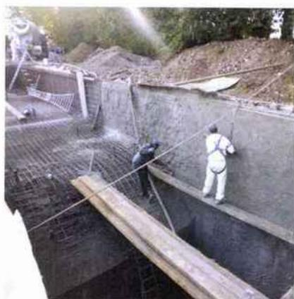
*Mélange de béton et de sable, la gunite est projetée par voie sèche sur le ferrailage de la piscine, en continu et par couches successives. La coque en gunite réalisée est compacte et homogène. Cette technique permet toutes formes de bassin. Diffazur*
