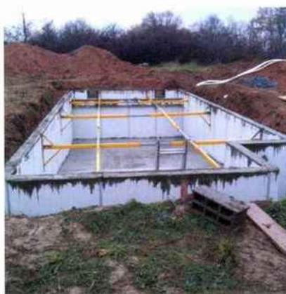
Le procédé **STRUCTURA**, concept breveté, permet de réaliser des piscines en béton armé banché monobloc. Sans rupture de pont, il confère solidité et longévité et permet de fabriquer des bassins en béton armé avec des hauteurs de parois multiples. **Everblue**
