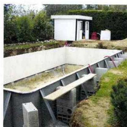
Steeltech® Protec est un procédé de fabrication sans soudure ni rivet. C'est un ensemble de panneaux en acier galvanisé avec un revêtement PVC assurant la finition des panneaux. La structure est renforcée à l'arrière par des jambes de force. **Aquilus Piscines**
